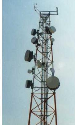
**Ilustración 3 - Antenas de Microondas<sup>3</sup>-**
