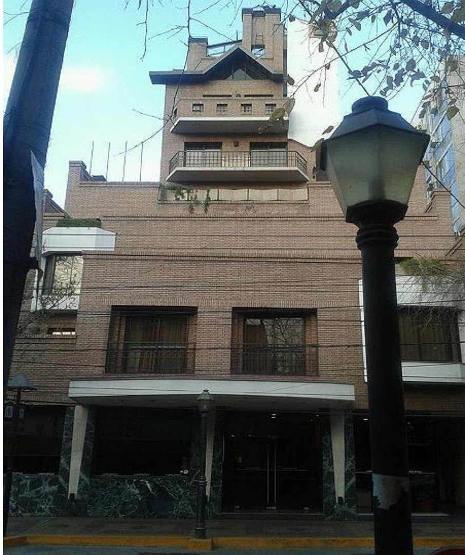
Vista frontal, Entrada Principal, calle San Juan
