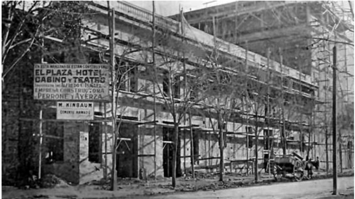
El Hotel Plaza y el Teatro Independencia en plena construcción en 1923. (Fotos mendozantigua.blogspot.com)
