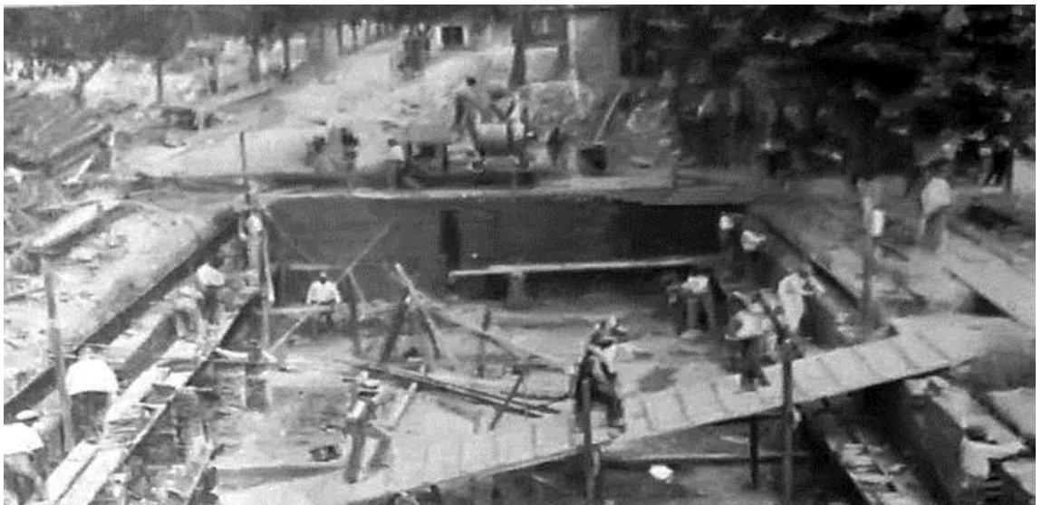
Los obreros cavan los cimientos del Hotel Plaza.
