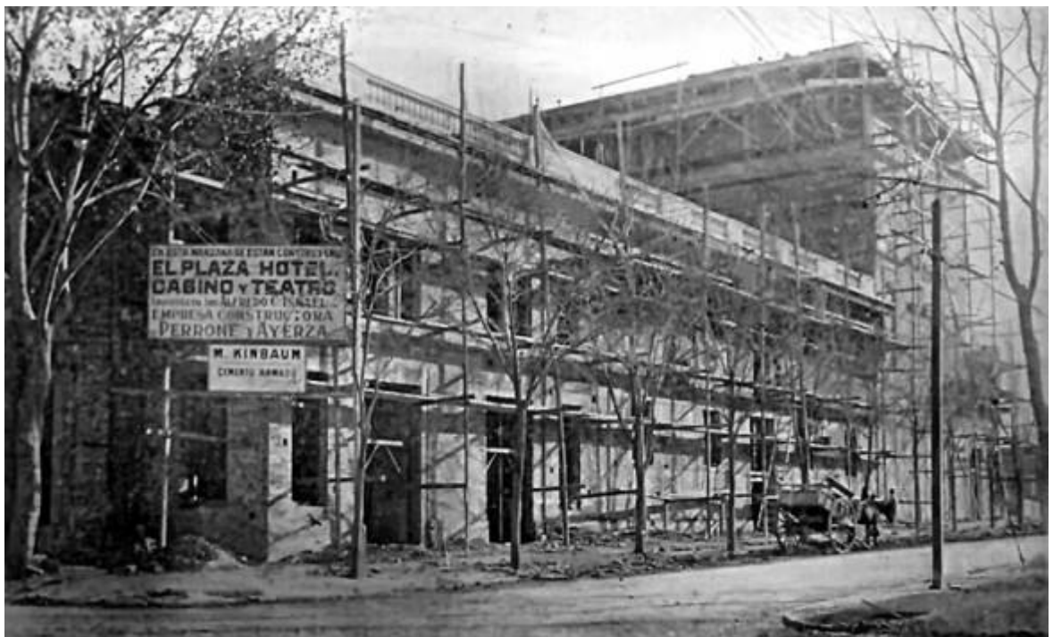
El Hotel Plaza contaba con dos pisos y un subsuelo destinado a las cocinas, despensas y depósitos.
