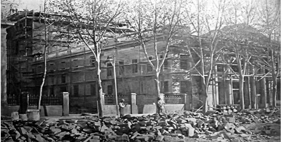
La obra del Hotel Plaza y del Teatro Independencia vista desde la calle Chile.
