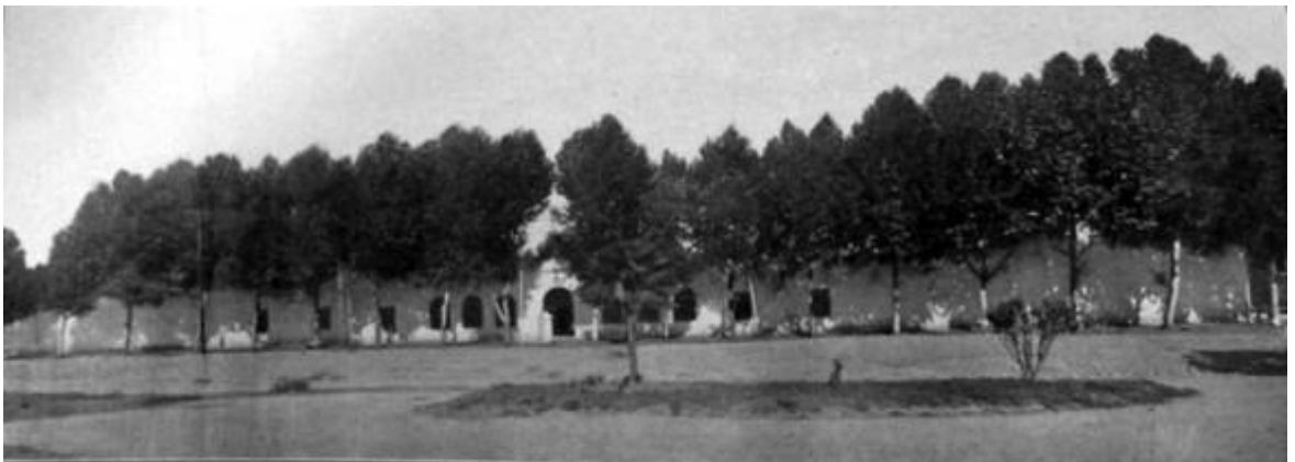
Fotografía de 1920 del Cuartel de Bomberos días antes de su demolición.
