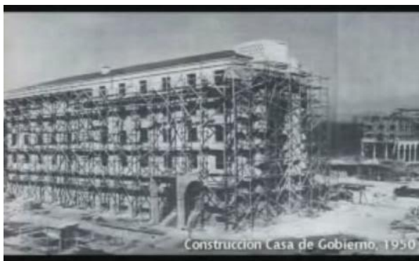
Construcción del Ala Este (1950)
