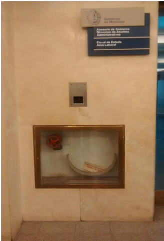
Bocas de Hidrante vacío
