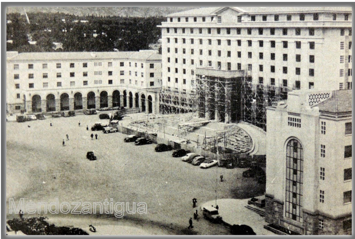
ULTIMOS TRABAJOS (Inaugurado en 1951)
