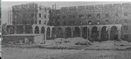
Construcción del Ala Oeste (1951)
