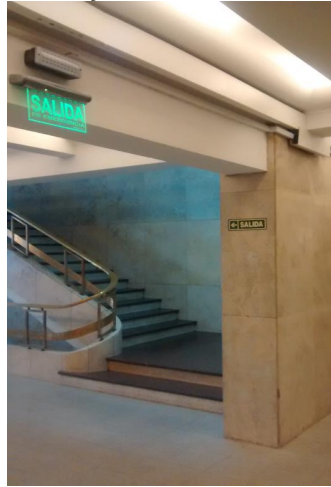
Cartel y Escalera
