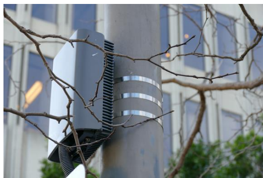
Figura N° 54: PicoCelda en San Francisco de la compañía Verizon, instalada en enero de 2016, usando tecnología C-RAN. 86
