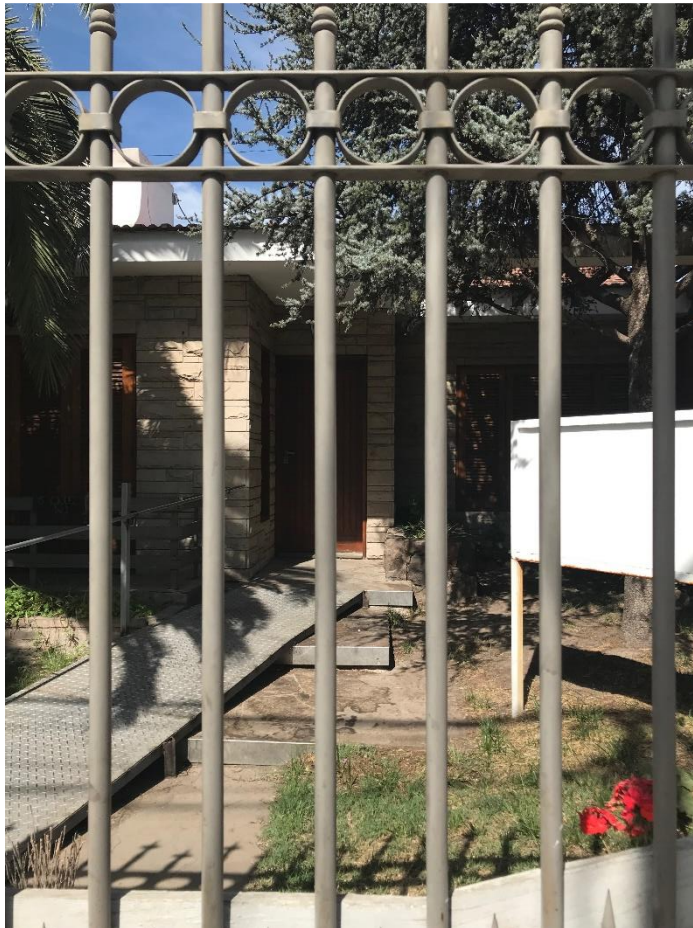
Figura 7. Vista desde la vereda. Salud Mental, Hospital Paroissien
